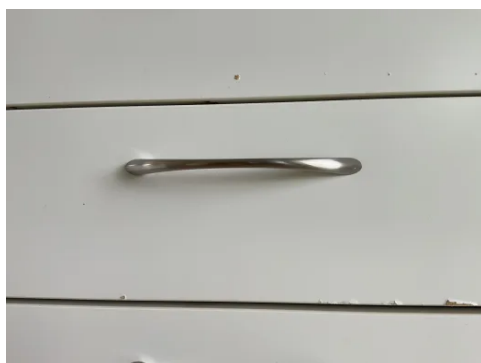
Noe avflassing og lokal slitasje
