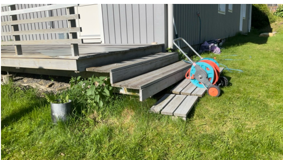
Utvendig trapp har enkel utførelse.
