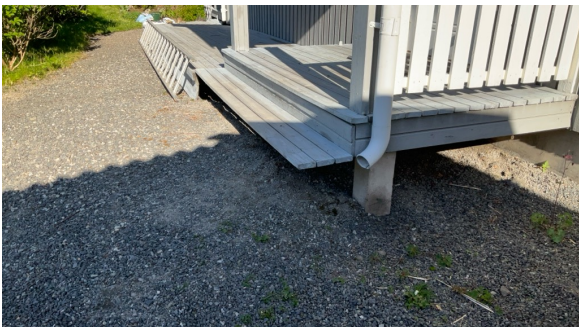
Utvendig trapp har enkel utførelse.
