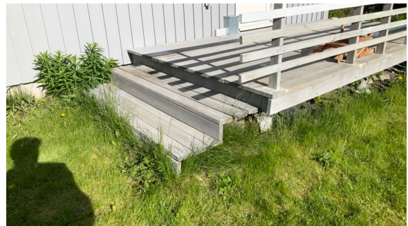
Utvendig trapp har enkel utførelse.
