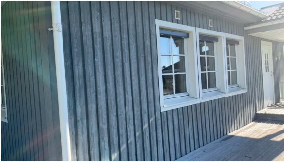
På befaringsdagen var kledning værslitt. Opplyst at dette blir malt før salg.
