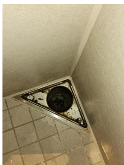
Tettesjiktets tilslutning til sluk - Sluk
