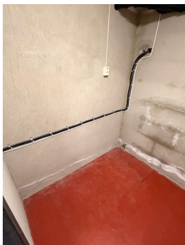
Saltutslag på vegg, tørre forhold på befaringsstidspunktet.
