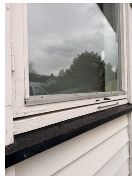
Vindu med malingsflassing utvendig.
