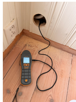
Ved fuktmåling ble det ikke registrert unormale forhold.
