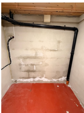
Saltutslag på vegg, tørre forhold på befaringsstidspunktet.
