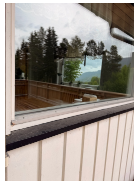
Vindu med malingsflassing utvendig.
