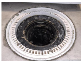
Tettesjiktets tilslutning til sluk - Sluk
