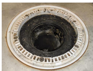
Tettesjiktets tilslutning til sluk - Sluk i dusj
