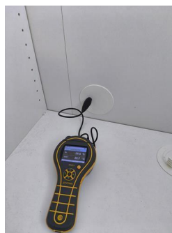
Utført kontroll i tiliggende konstruksjon - Fuktmåling
