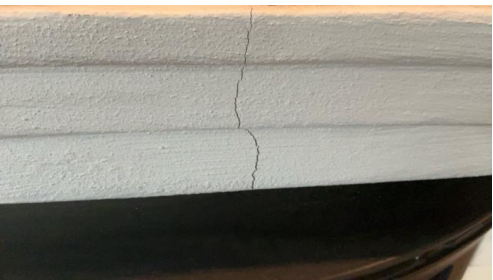
Sprekk i mur.
