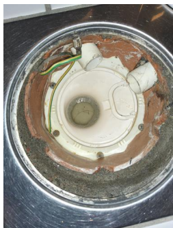
Tettesjiktets tilslutning til sluk - Hovedsluk
