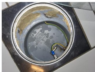
Tettesjiktets tilslutning til sluk - Hjelpesluk
