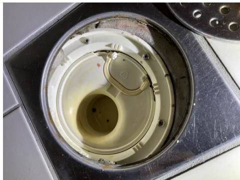
PVC-sluk med stakemuligheter
