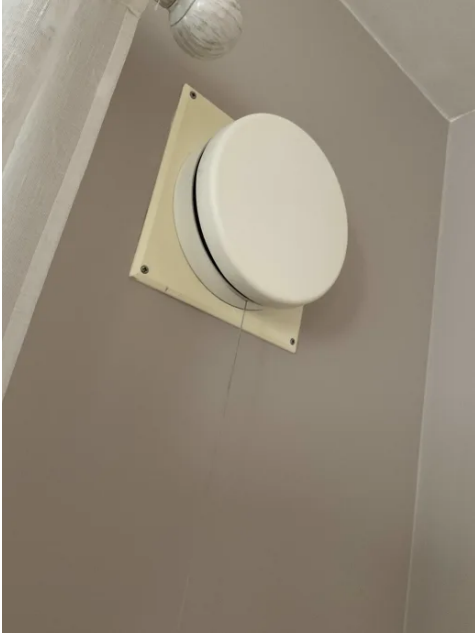
Naturlig ventilasjon med lufteventiler ført via yttervegg
