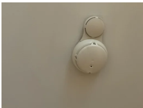
Seriekoblet brannvarslere for boligsamiet
