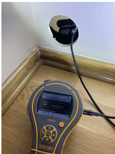
Fuktsøk med hulltaking, ingen unormale verdier
