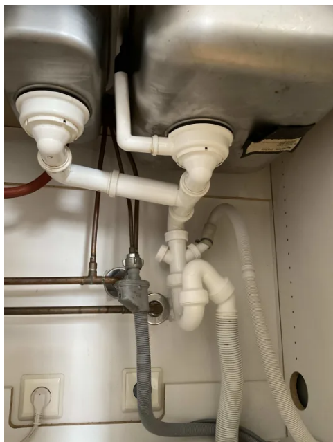
Synlige avløpsrør med PVC-plast
