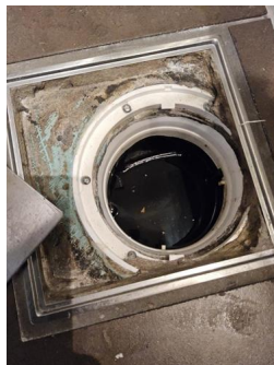
Tettesjiktets tilslutning til sluk - Sluk.
