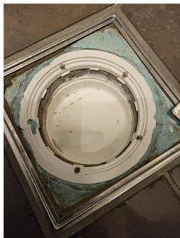
Tettesjiktets tilslutning til sluk - Sluk.
