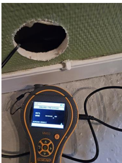
Utført kontroll i tilliggende konstruksjon - Fuktmåling.
