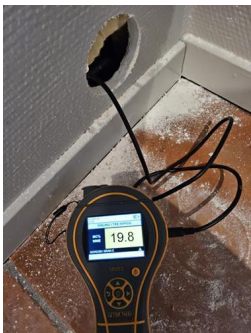
Kontroll i lukkede konstruksjoner - Fuktmåling.
