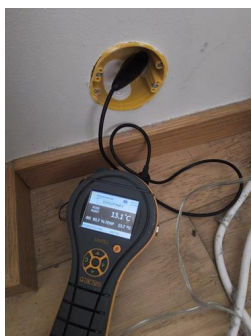
Kontroll i lukkede konstruksjoner - Fuktmåling
