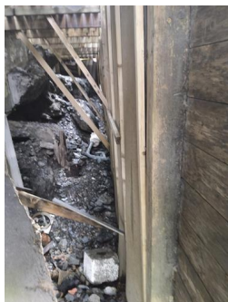
Konstruksjon og fundamenter - Underside balkong
