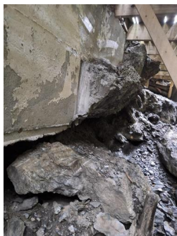
Grunnmur og fundament - Grunnmur under balkong
