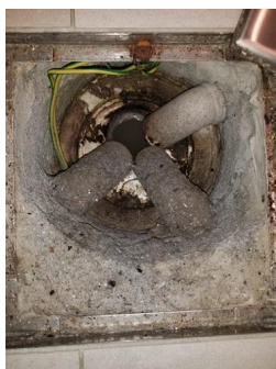
Vanntett sjikt / membran i gulv og vegger - Hovedsluk bad
