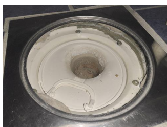
Tettesjiktets tilslutning til sluk - Sluk
