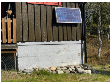
Takvann ført ut på terreng
