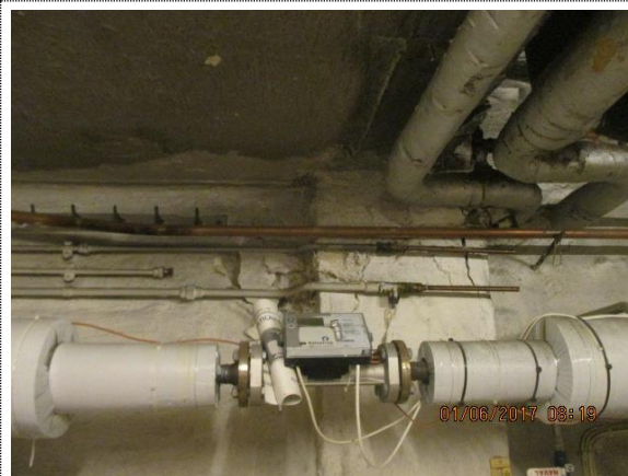
Bilde nr. 20 Fjerne gamle varmerør og oljepåfyllingsrør.
