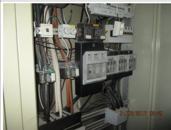
Bilde nr. 30 Fjerne og koble løse ledninger i tavle.
