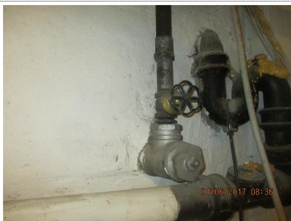
Bilde nr. 23 Fjerne gamle gassrør.
