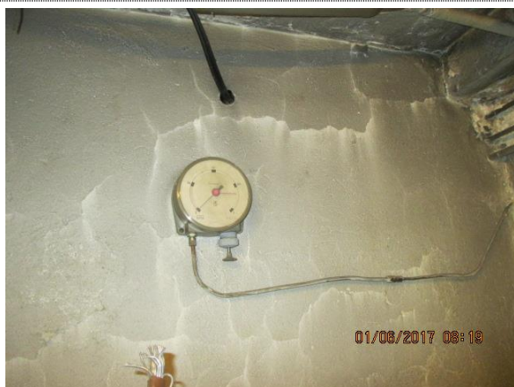
Bilde nr. 21 Fjerne gamle varmerør og oljepåfyllingsrør.
