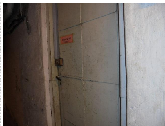
Bilde nr. 14 I kjelleren er det registrert enkelte dører som ikke lenger tilfredsstill kravene til brann- og røyktetthet.
