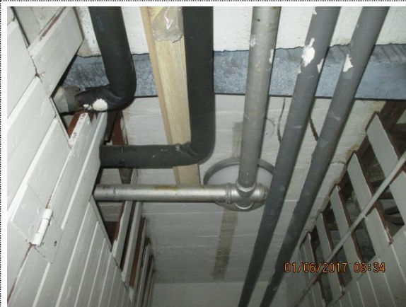
Bilde nr. 22 Fjerne gamle gassrør.
