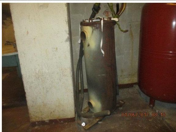
Bilde nr. 19 Fjerne gammelt varmeanlegg.
