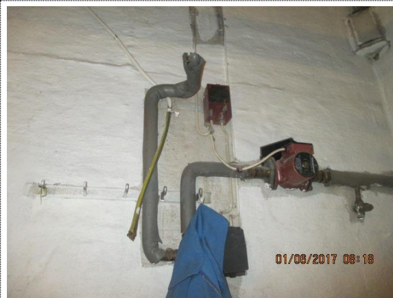
Bilde nr. 26 Terminer/koble frakoplet jordledning.
