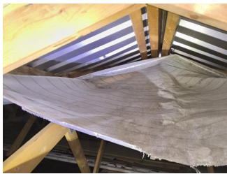
Synlige overflater (taktro, vegger, gulv, o.l.) - Åpning/skade i undertak
