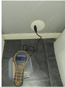
Utført kontroll i tilliggende konstruksjon - Fuktmåling
