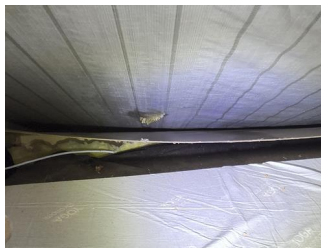
Synlige overflater (taktro, vegger, gulv, o.l.) - Skade i undertak som er tettet med fugemasse
