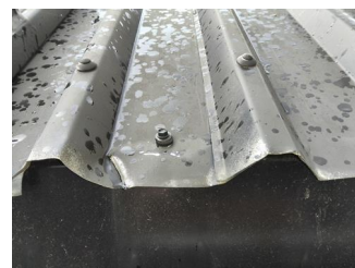
Tekking (med tilhørende beslag) - Skade og slitasje i nedre del av takplater
