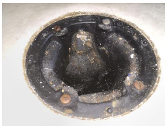
Tettesjiktets tilslutning til sluk - Sluk
