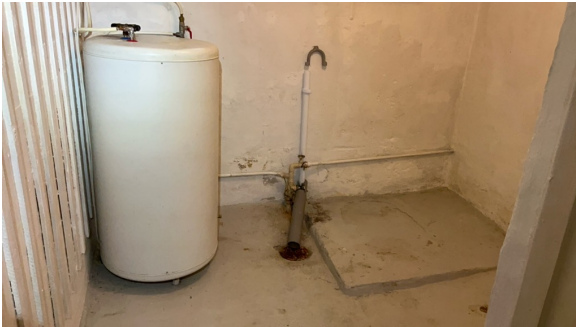
Vaskerom i kjeller.
