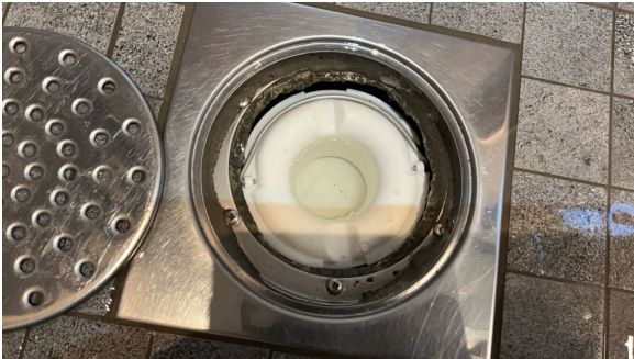
Kontroll av sluk.
