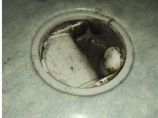
Tettesjiktets tilslutning til sluk - Sluk
