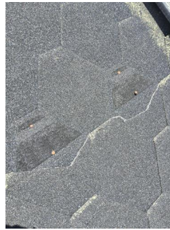
Tekking (med tilhørende beslag) - Skadet shinel
