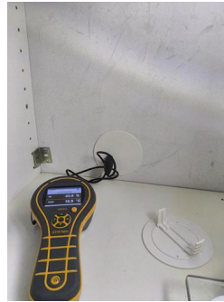
Utført kontroll i tiliggende konstruksjon - Fuktmåling
