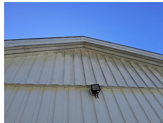
Ytterkledning (fasademateriale, vannbord, utvendig listverk, o.l.) - Svertesopp/slitasje av kledning observeres.
