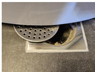
Avløp (inkl. sluk) - Sluk fra byggeår
