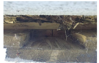
Lufting av ytterkledning - noe mindre lufting
