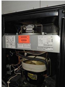
Tekniske anlegg (kjøleaggregat, badstueovn med mer) - .
