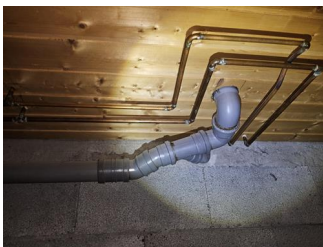
Avløprør (utover det som nevnes under andre sjekkpunkter) - Vann og avløpsrør fra byggeår
