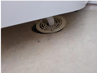
Avløp (inkl. sluk) - Sluk og gulvbelegg fra byggeår
