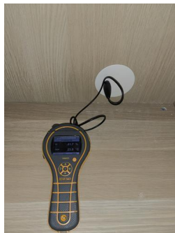
Utført kontroll i tilliggende konstruksjon - Fuktmåling
