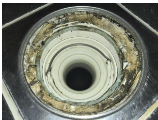
Tettesjiktets tilslutning til sluk - Sluk
