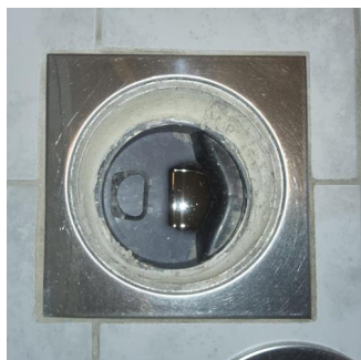
Avløp (inkl. sluk) - Sluk utenfor dusjsonen
