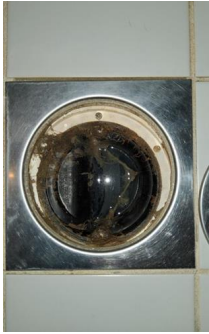
Tettesjiktets tilslutning til sluk - Sluk bad
