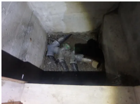
Sammenkobling drenering i utvendig kjellernedgang.
