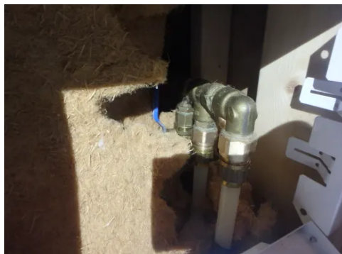
Koblingspunkt i vegg på stue mot øst.
