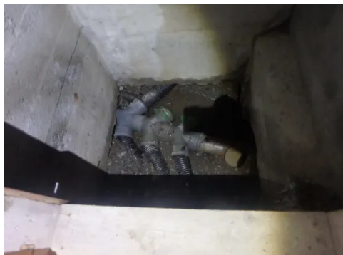
Sammenkobling drenering i utvendig kjellernedgang.
