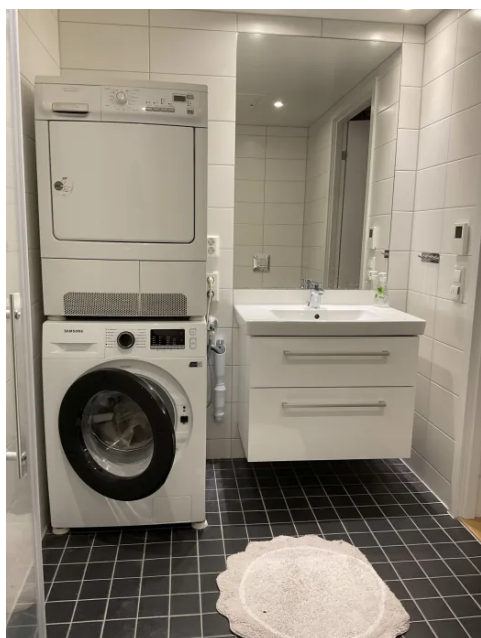
Baderom med opplegg for vaskemaskin
