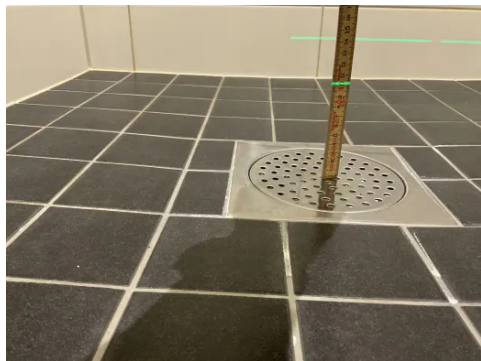
Tilfredstillende fallforhold til sluk
