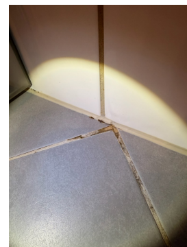
Svertesopp og delvis oppsprekking i silikonfuger.
