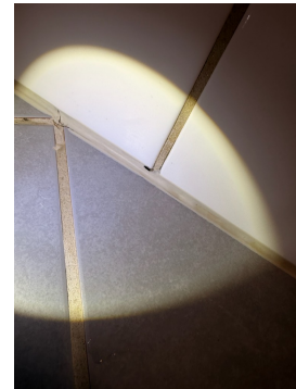
Svertesopp og delvis oppsprekking i silikonfuger.
