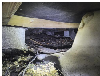
Annet - Løse plater i bjelkelaget
