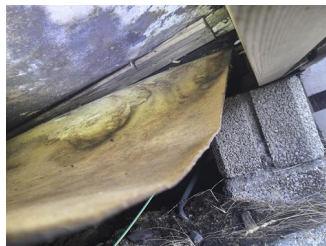
Annet - Løse plater i bjelkelaget
