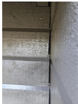
Innendige forhold - Åpninger i kledning
