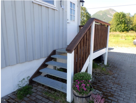
Trapp ved inngangsparti
