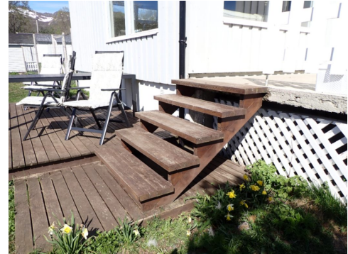
Trapp til veranda
