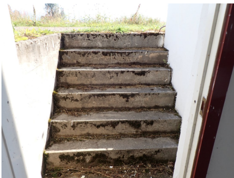
Trapp til kjellerinngang
