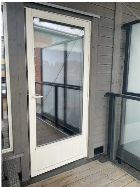
Terrassedør med isolerglass
