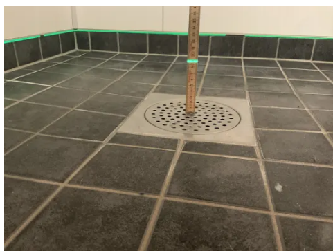
Tilfredsstillende fallforhold til sluk
