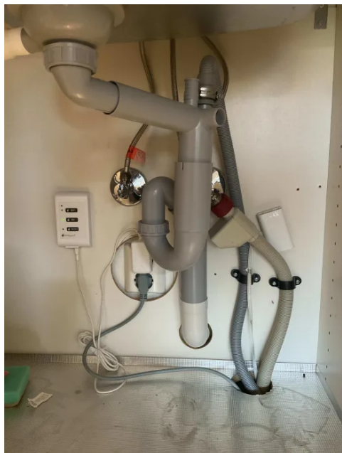
Synlige innvendig avløpsrør med PVC-plast
