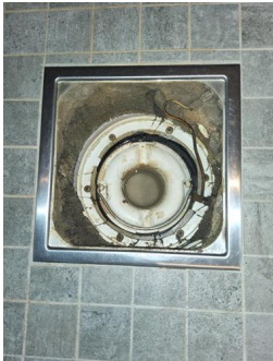
Tettesjiktets tilslutning til sluk - Sluk bad
