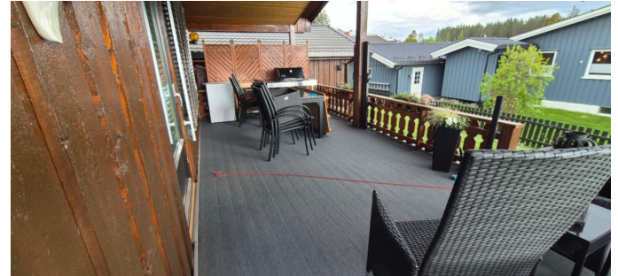
Veranda mot sør
