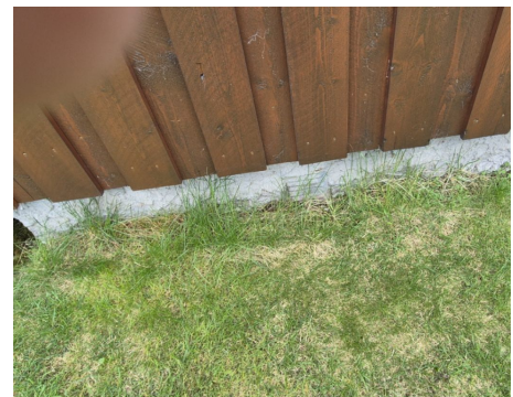
Ventiler til krypkjeller
