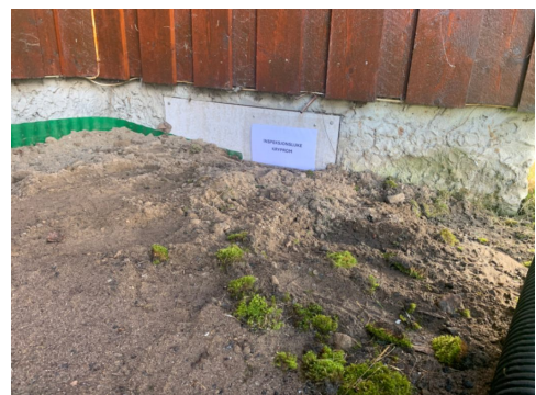
Lukke og skilt ved luke til krypkjeller
