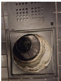
Tettesjiktets tilslutning til sluk - .
