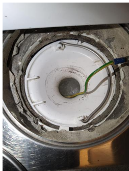
Tettesjiktets tilslutning til sluk - Hovedsluk
