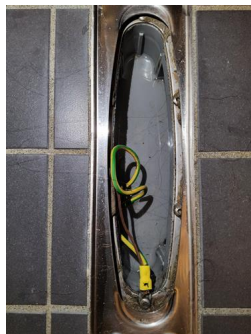
Tettesjiktets tilslutning til sluk - Rennesluk i dusjsone.
