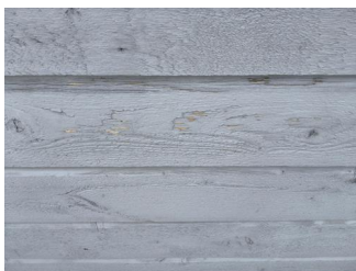
Overflatebehandling - Slitt overflatebehandling
