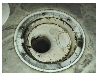
Tettesjiktets tilslutning til sluk - Sluk
