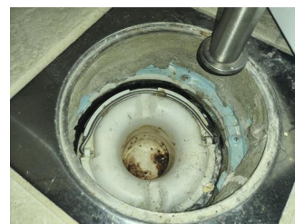
Tettesjiktets tilslutning til sluk - Sluk bak skyvedør
