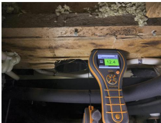
Stikktaking i treverk, fukt og fuktmålinger - Fuktmåling
