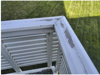
Utvendig trapp - Slitt overflatebehandling
