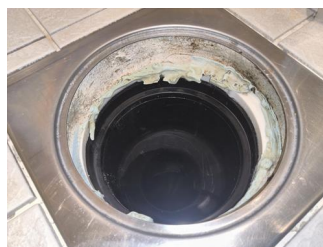
Tettesjiktets tilslutning til sluk - Sluk i dusj
