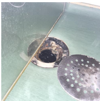
Helhetsvurdering - Sluk under innredning
