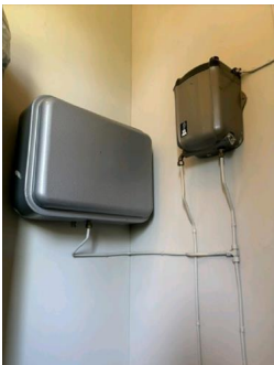
Oljetank - Dagtank i kjellertrapp
