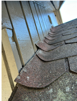
Overgang tak/vegg terrasse og yttervegg.
