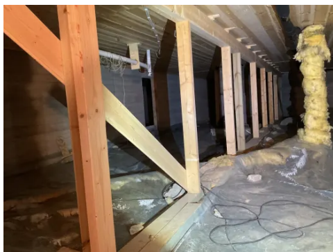
Tilfredstillende utførelse med dampsperre etablert mot grunne
