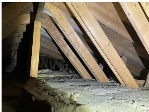
Takkonstruksjon utført med plassbygde sperrer
