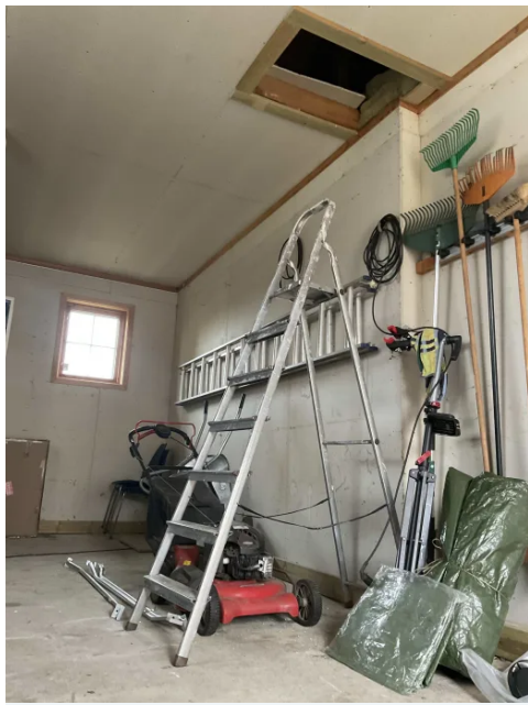
Adkomst til kaldtloft via himlingsluke i inntilbygget garasje
