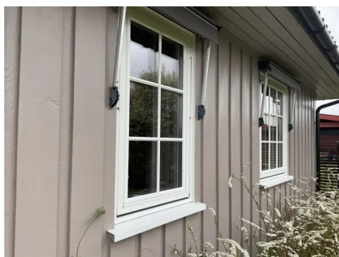
Nedre vannbrett med beslag
