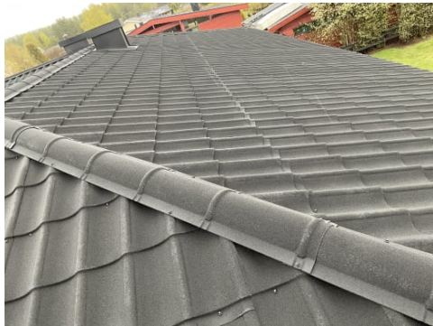
Taktekkingen er besiktet oppe på taket
