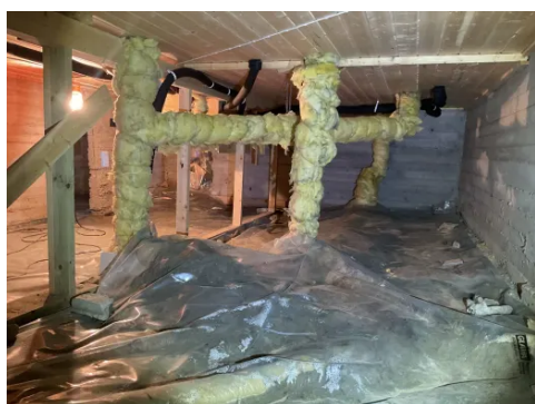
Isolerte avløpsrør via krypkjeller
