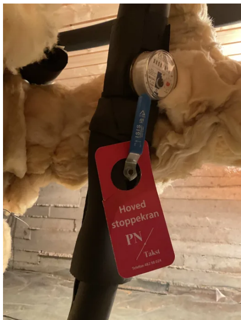
Hovedstoppekran med synlig merking
