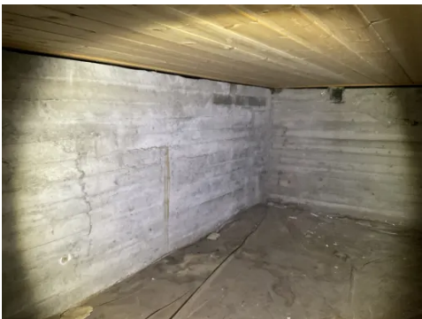
Grunnmurer oppført i betong
