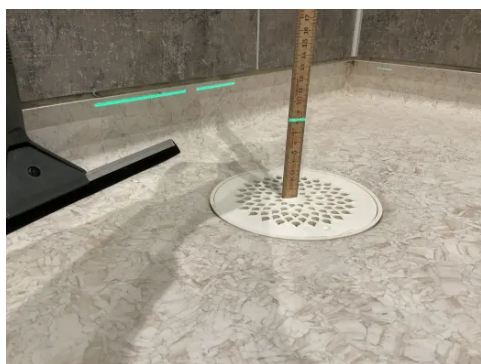
Tilfredsstillende fallforhold til sluk
