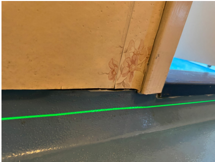
Utett overgang mellom belegg og tapet
