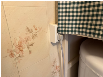
El. tilkobling av bereder
