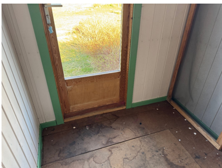
Slitte huntonittplater i bod
