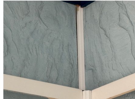
Unøyaktig tilpasning av baderomsplate bak dusj
