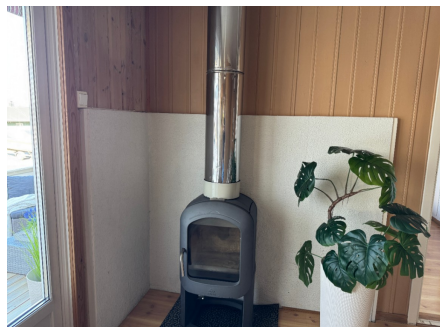
Vedovn og stålpipes i stue
