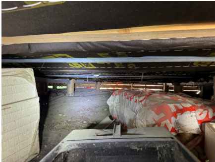
Bilde av kryperom under boligen
