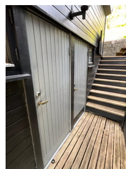
Ytterdør til oppholdsrom over garasje og inn til bod
