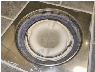
Tettesjiktets tilslutning til sluk - Sluk
