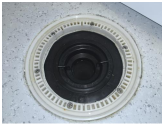
Overflate gulv - Sluk bod
