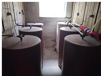
Varmtvannsbereder - Varmtvannsbereder.
