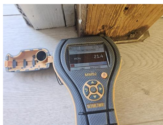
Overflate vegg - Fuktmåling yttervegg.
