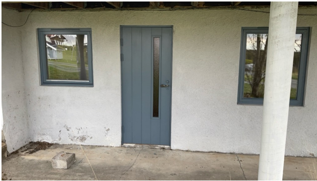
Inngangsdør til underetasje.
