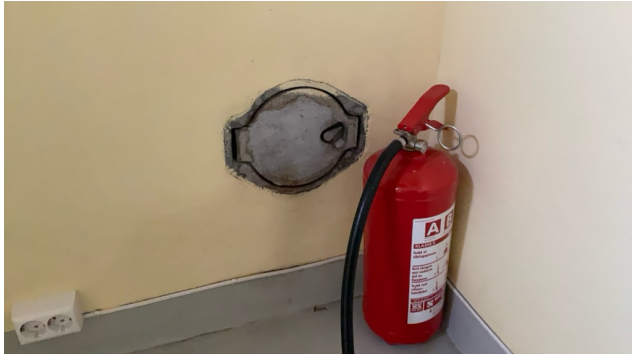
Feieluke i kjeller. Betonggulv under feieluke.
