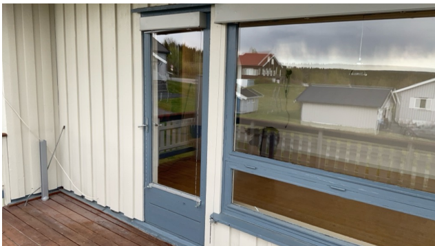
Dør til balkong fra stue.
