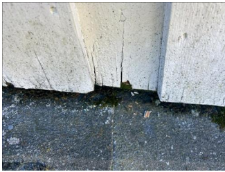
Ytterkledning (fasademateriale, vannbord, utvendig listverk, o.l.) -
