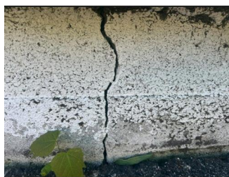
Grunnmur og fundament - -
