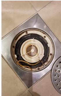
Tettesjiktets tilslutning til sluk - Sluk i dusjen.
