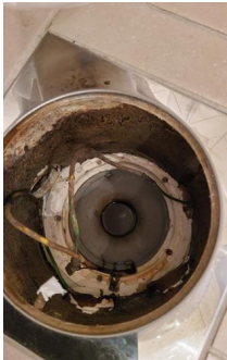
Tettesjiktets tilslutning til sluk - Sluk bad
