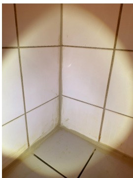
Fugingen i dusjen fremstår ufagmessig utført.
