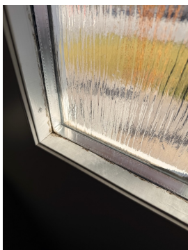
Innvendig kondensering i glass på ytterdør.
