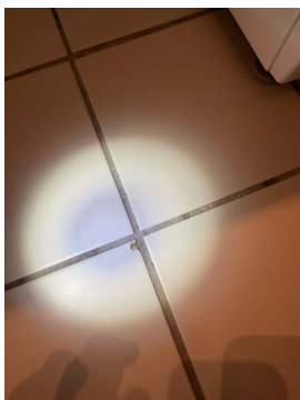
Fugingen i dusjen fremstår ufagmessig utført.
