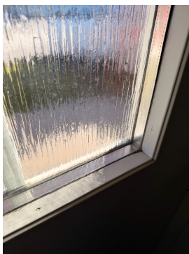
Innvendig kondensering i glass på ytterdør.
