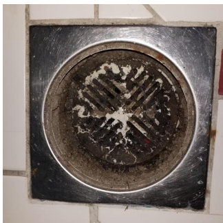
Vanntett sjikt / membran i gulv og vegger - Sluk vaskerom i 1.etasje.
