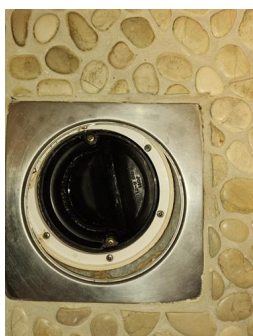
Tettesjiktets tilslutning til sluk - Sluk bad
