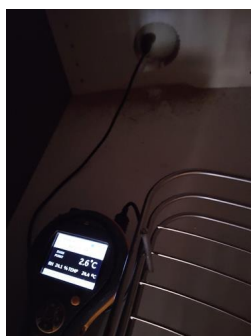
Utført kontroll i tilliggende konstruksjon - Fuktmåling bad
