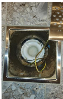
Tettesjiktets tilslutning til sluk - Sluk bad
