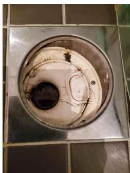
Tettesjiktets tilslutning til sluk - Sluk i dusjsonen.
