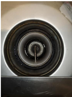
Tettesjiktets tilslutning til sluk - Sluk bad
